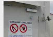
Rebord de protection pluie et système de maintien des portes avec fermeture automatique
