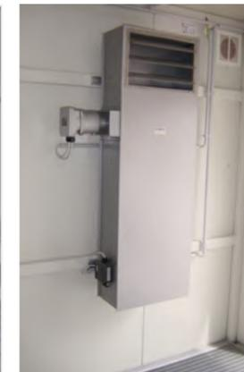
Chauffage à circulation d'air
