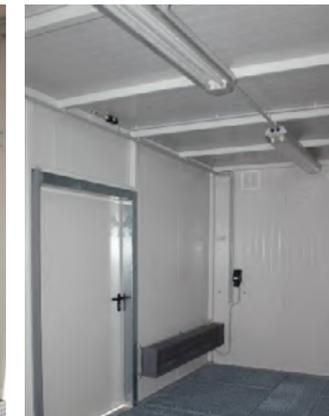
Vue intérieure avec luminaire Led long et radiateur tube à ailettes
