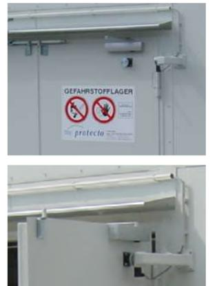
Système de fermeture des portes avec électro-aimant, fermeture automatique de portes en cas de détection de feu
