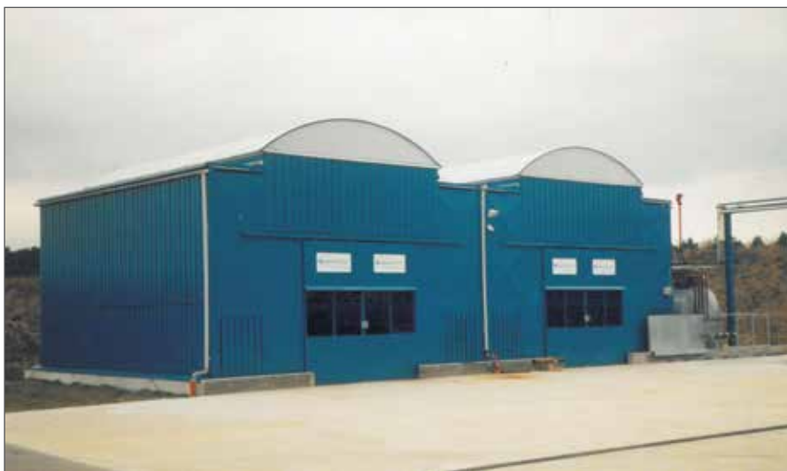
Magasin de stockage constitué de conteneurs stockage 3 niveaux
