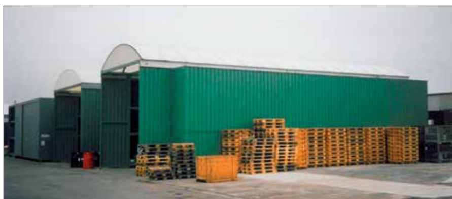
Trois magasins de stockage constitués de conteneurs multi-niveaux de 15 m de longueur chacun
