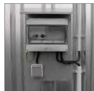
Boîtier à fusibles et interrupteur, référence 20266
