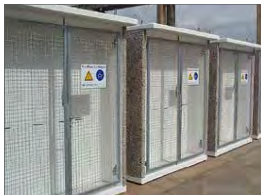
Locaux pour bouteilles de gaz de type GFL-B installation en ligne
