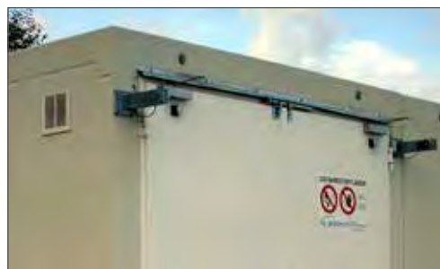
Système de maintien de porte avec fermeture automatique
