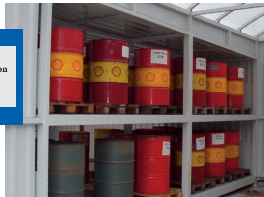
Conteneurs multi-niveaux pour stockage de fûts
